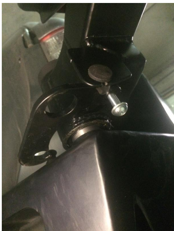
28. Прикручиваем пластину стопора к калитке (Болт М8х30)
